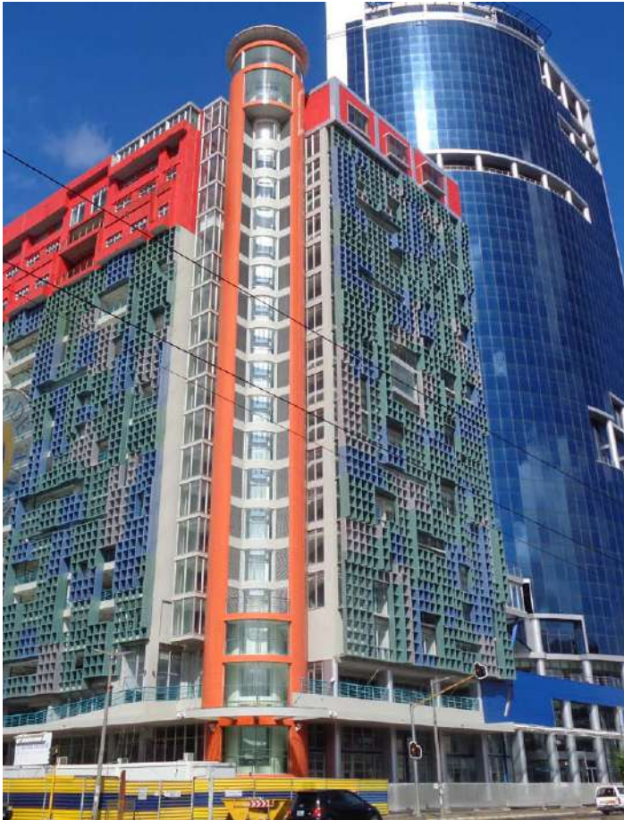
Teixeira Duarte – Engenharia e Construções (Moçambique), Lda. Banco de Moçambique – Maputo | Mozambique
