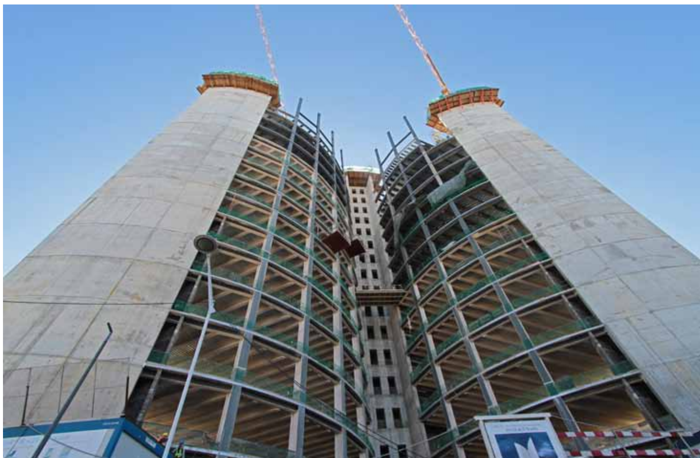
Montagem de estruturas metálicas – Nova Sede Social do Gulf Bank Algerie – Argel | Argélia
