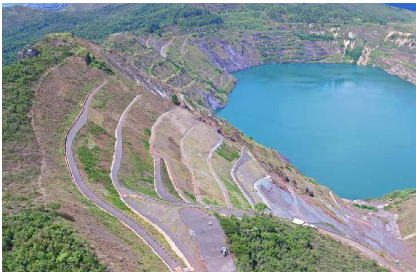
Estabilização de taludes no Setor Cava Oeste – Mina de Águas Claras – Nova Lima – Minas Gerais | Brasil
