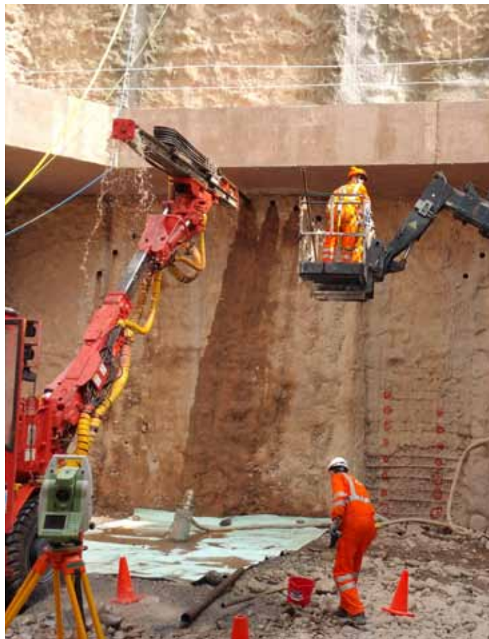
E.P.O.S. – Empresa Portuguesa de Obras Subterrâneas, S.A.: Escavação e revestimento de galerias – Metro de Lima Lima | Peru
