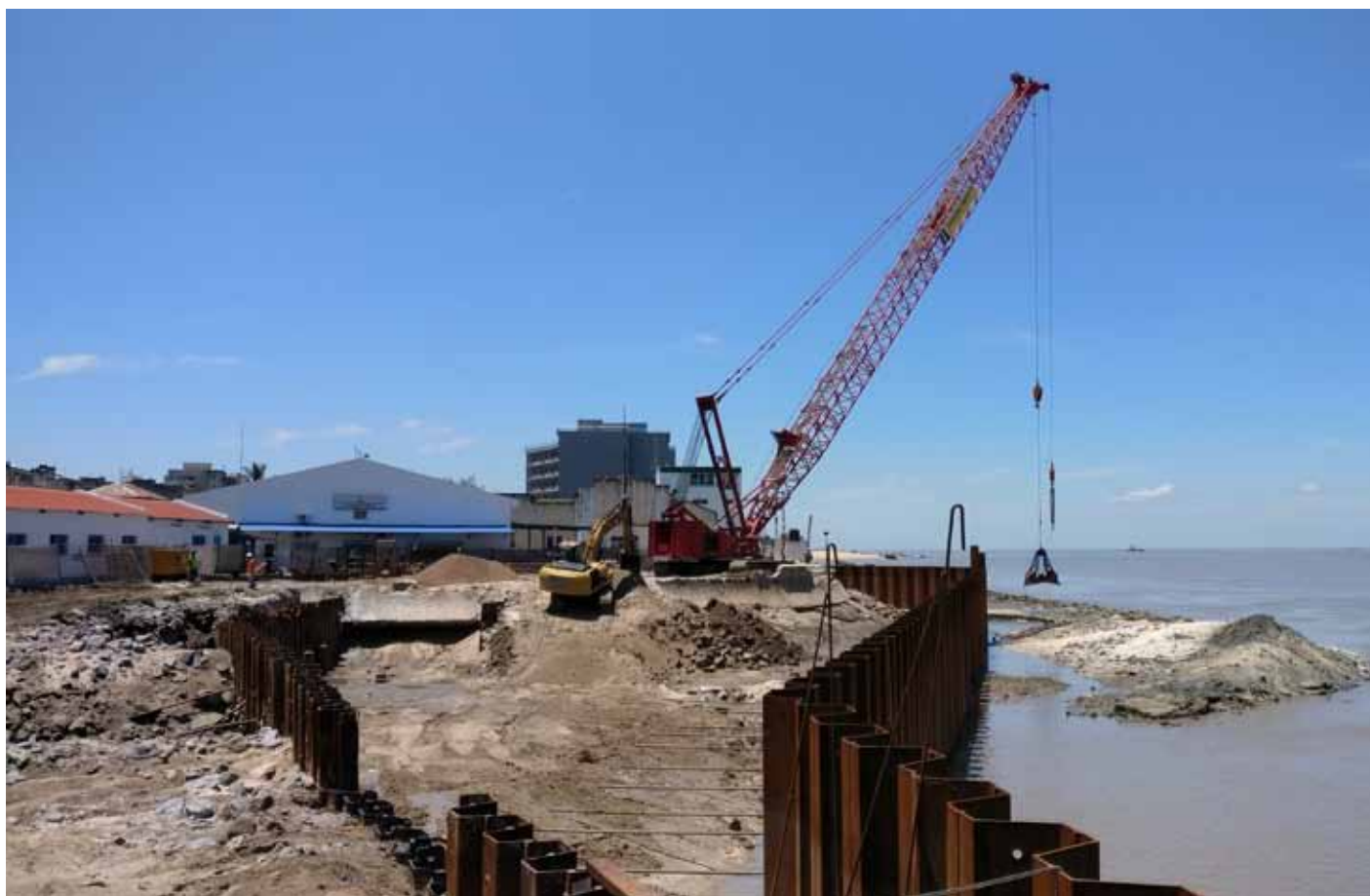
Reabilitação e ampliação do cais do Porto da Beira - Beira | Moçambique
