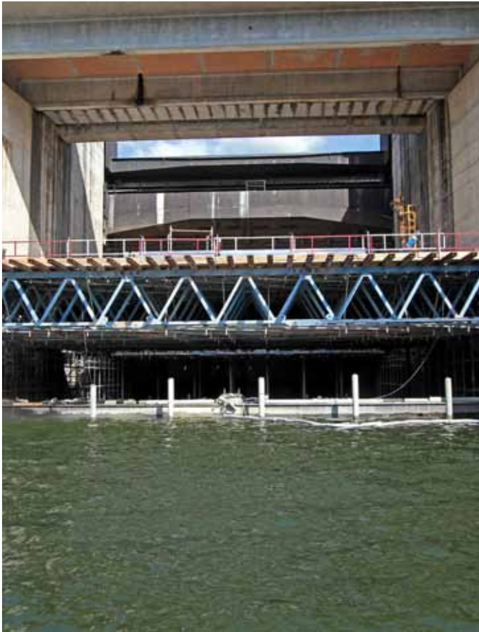
Centro Operacional de Cofragens e Pré-Esforço Execução de plataforma para trabalhos de geotecnia Barragem de Crestuma-Lever | Portugal
