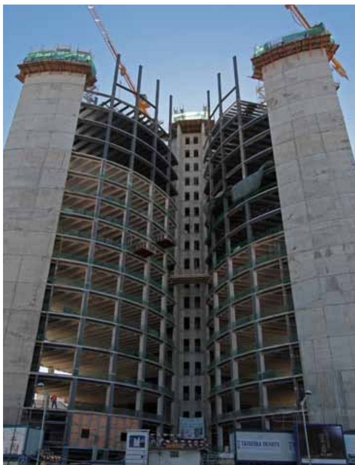
Edificações – Gulf Bank Algeria – Alger | Argélia
