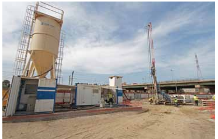
EMPA S.A. Serviços de Engenharia Fundações no Terminal de São Luís do Maranhão | Brasil Teixeira Duarte Algérie, SPA Microestacas e Jet grouting – Oued Ouchayah | Argélia
