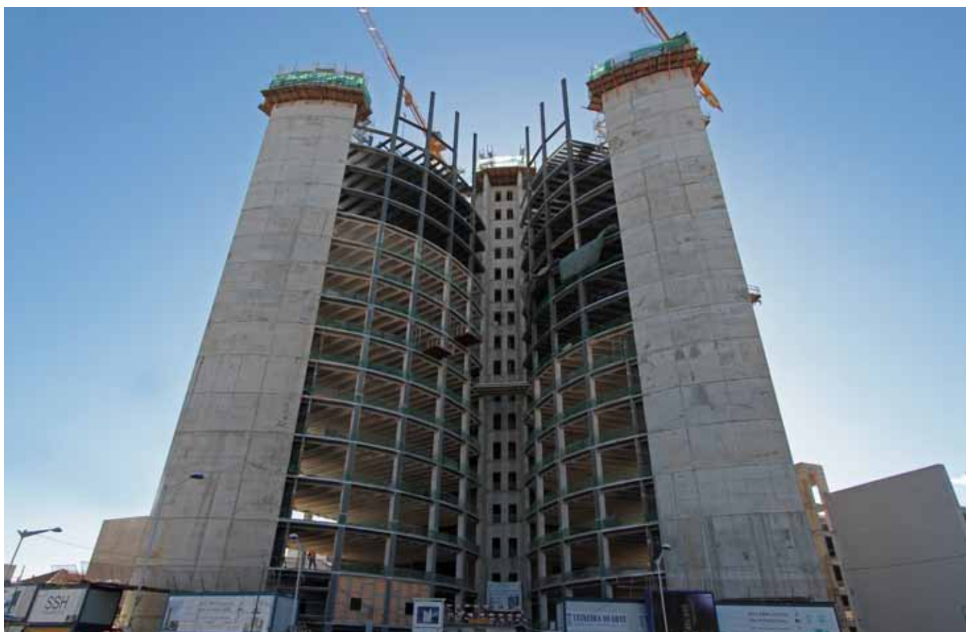
Construção da nova sede do Gulf Bank Algeria - Argel | Argélia
