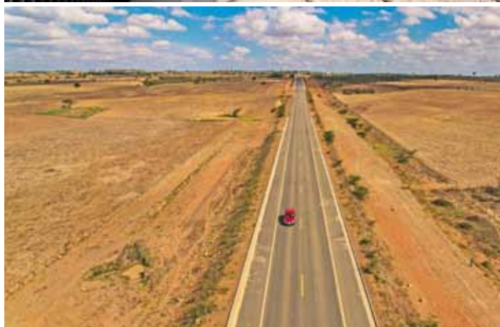
Trabalhos de modernização da Linha Thenia/Tizi-Ouzou – Estação de Bordj Manaiel Boumerdès | Argélia Construção da Rodovia BR 235/BA – Coronel João Sá Bahia | Brasil
