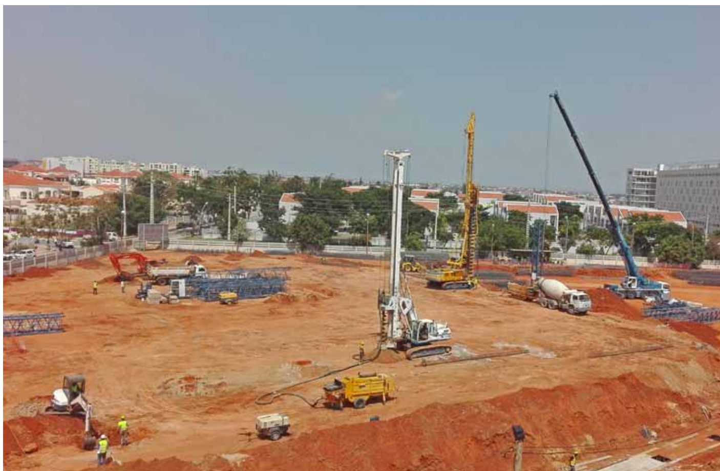
Fundações indiretas do edifício Talatona 2 – Luanda | Angola
